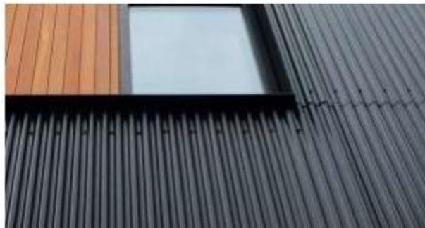
Figura 12. VISTA PREVISTA DE LAMINA PERFIL ONDULAR
